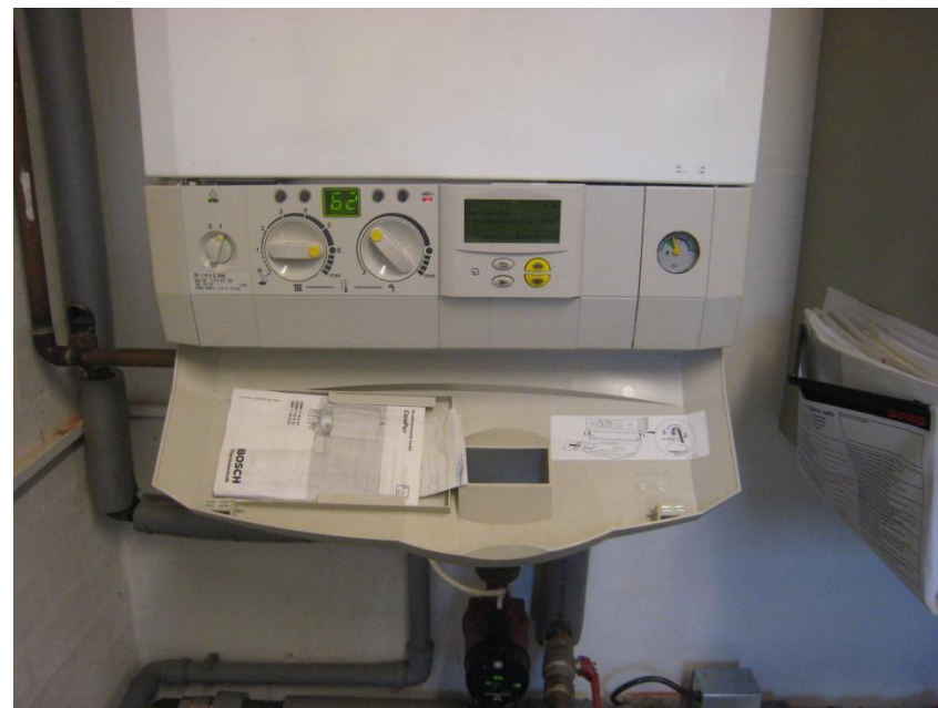
Betjeningspanel på en naturgaskedel. Fremløbstemperaturen reguleres automatisk efter udetemperaturen og vises i displayet.
